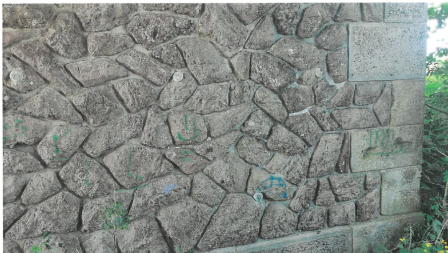
Obr. 1: Opěra spodní stavby mostu. Nároží a sokl jsou provedeny z kamenných nebo betonových pemrlovaných bloků.
