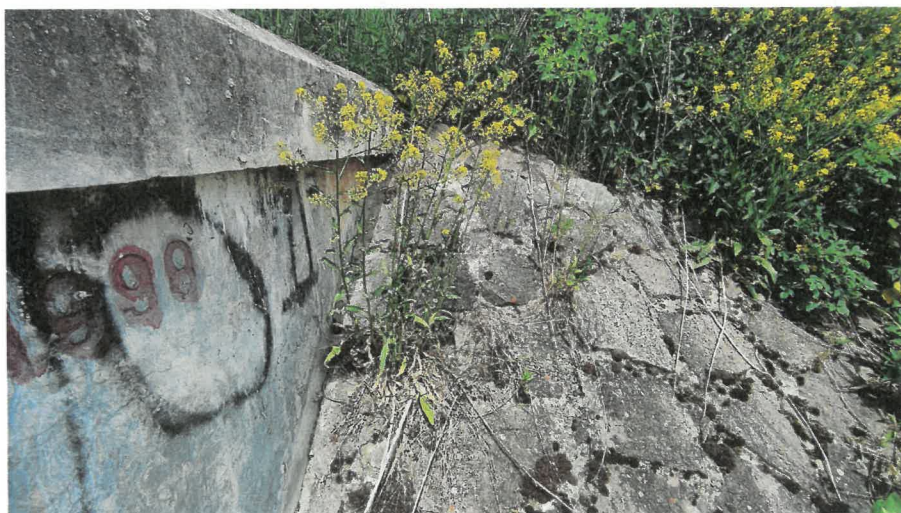
Obr. 3: Pokles a vodorovný posun křídla propustku.
