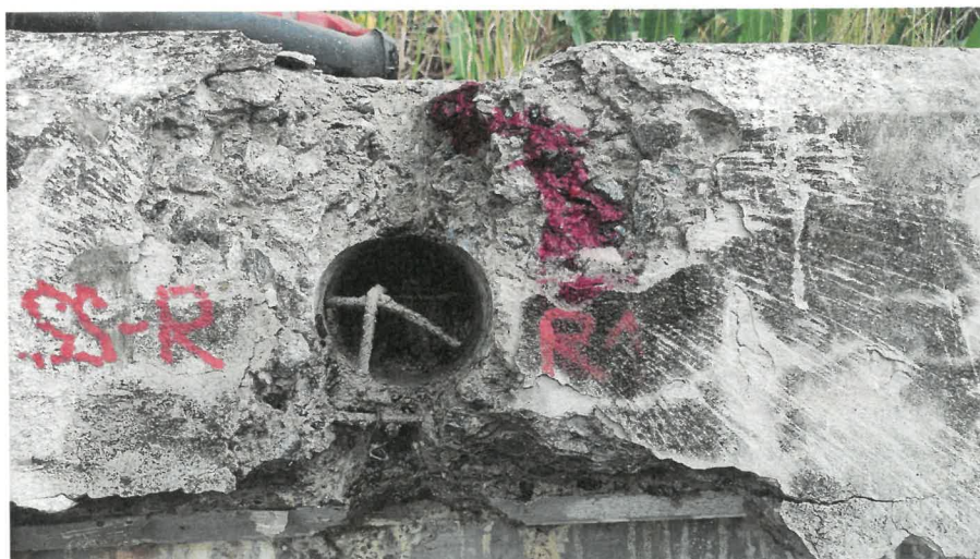
Obr. 9: Sekaná sonda v konstrukci římsy. Výztuž tvoří 2-3 vrstvy kari sítě 6/100/100 mm. Při sekání docházelo ke snadnému oddělování betonu, příčinou je rozrušení struktury betonu výše uvedenými korozními vlivy.
