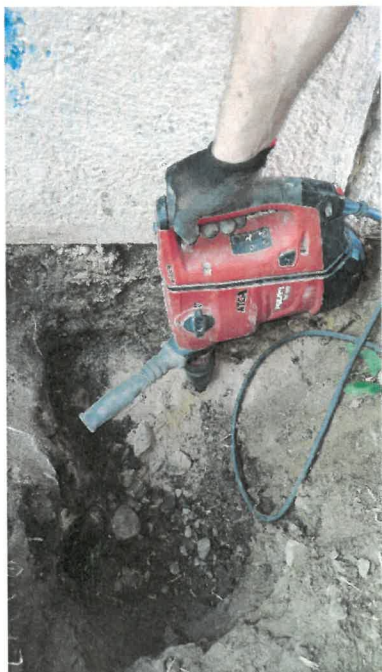
Obr. 24 a 25: Ověření úrovně základové spáry vrtanou sondou u opěry mostního objektu.
