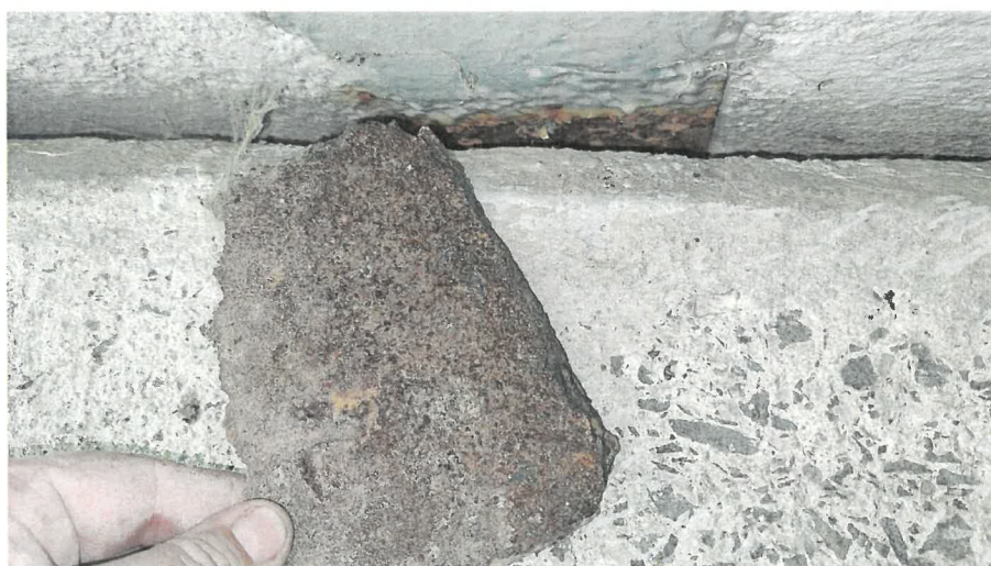
Obr. 7: Korozní poškození spodního líce ocelového prvku nad úložným prahem. Uvedené oblasti nosné konstrukce jsou u tohoto mostu obtížně přístupné a dochází ke korozi nosníků a k laminárnímu odlupování korozních zplodin z neošetřených částí ocelových profilů.
