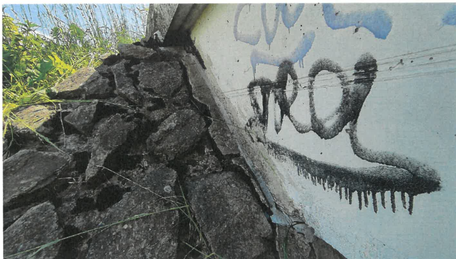
Obr. 22: Pokles kamenného obložení svahu podél kamenné opěry, křídla a římsového prefabrikátu mostního objektu.
