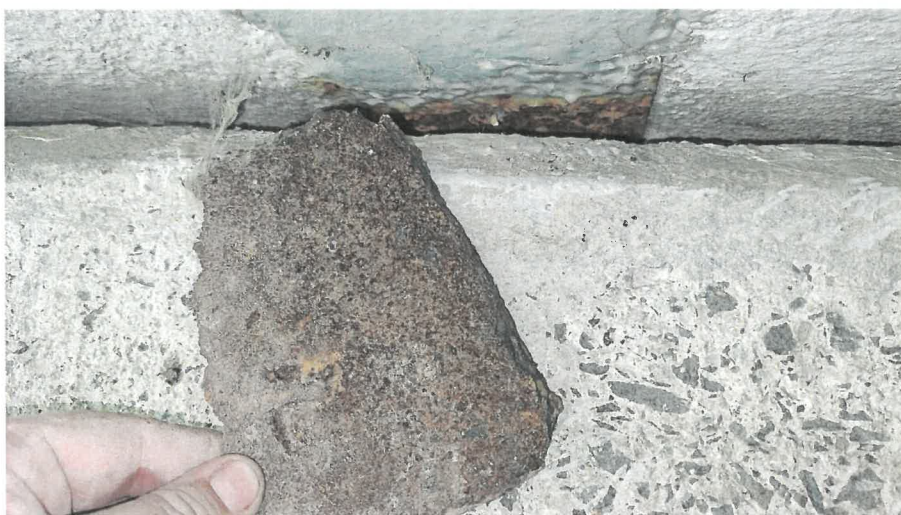
Obr. 17: Korozní poškození spodního líce ocelového prvku nad úložným prahem. Uvedené oblasti nosné konstrukce jsou u tohoto mostu obtížně přístupné a dochází ke korozi nosníků a k laminárnímu odlupování korozních zplodin z neošetřených částí ocelových profilů.
