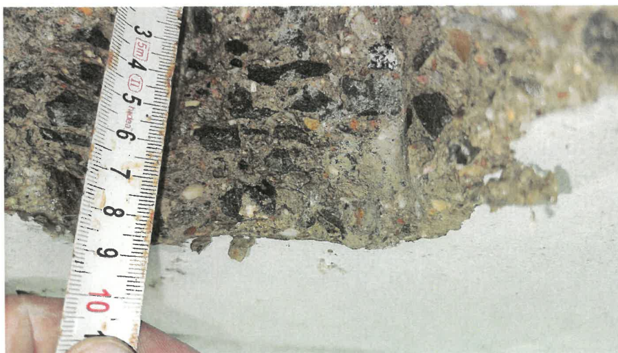
Obr. 21: Detail sekané sondy SS-R na spodním líci prefabrikovaného římsového nosníku. Betonářská výztuž nebyla do hloubky 80 mm od spodního líce prefabrikátu dohledána.
