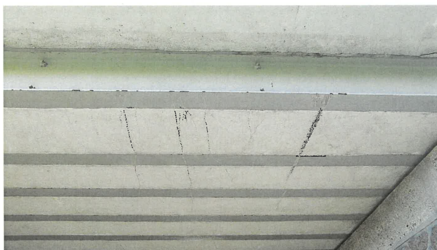
Obr. 14: Poškození nátěru krajních ocelových nosníků podjezdem nadměrného vozidla nebo jeho nákladu.
