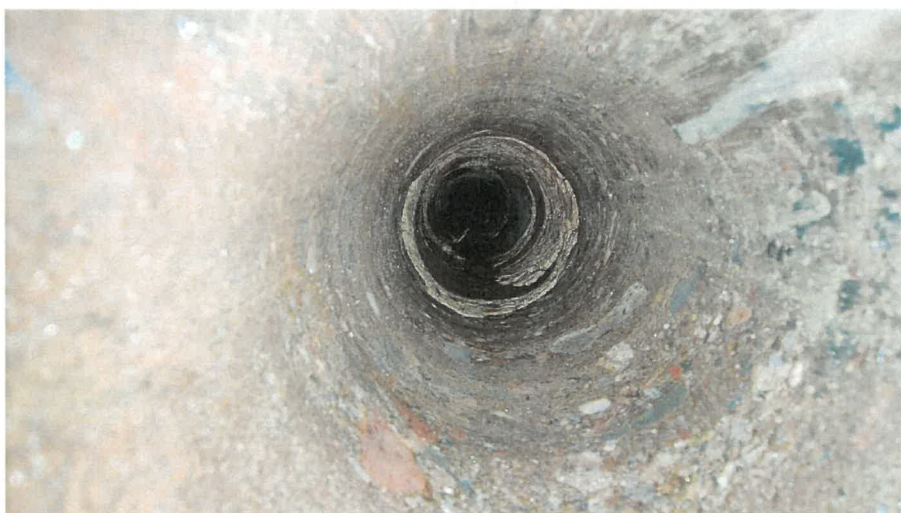
Obr. 5: Pohled do sondy po odběru jádrového vývrtnu 1-3, který byl odebrán z kamenného zdiva opěry mostního objektu.
