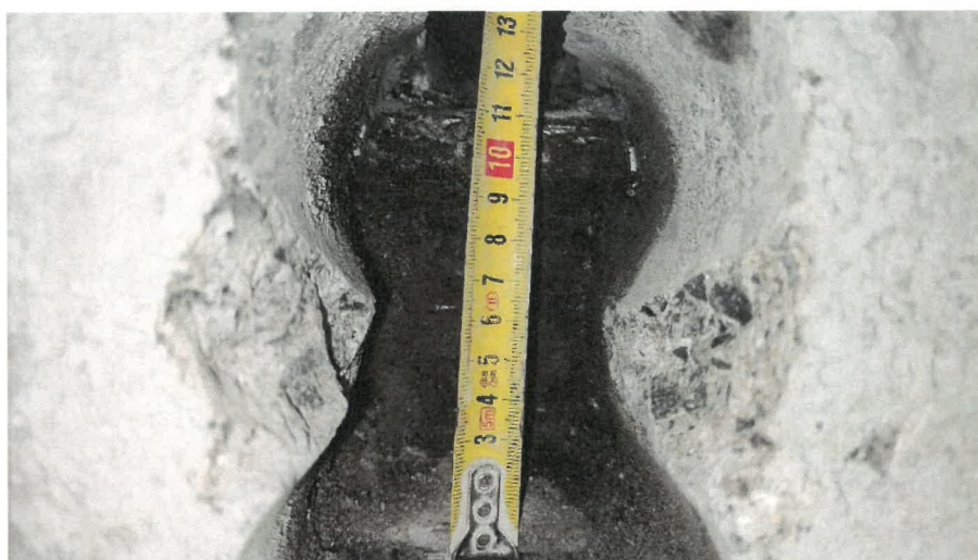
Obr. 11: Detail obnažené použité kolejnice s výškou 115 mm, která byla zjištěna v úložném prahu č. 2.
