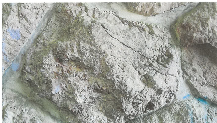
Obr. 3: Trhliny v místech vrstevnatosti nepravidelného kamenného bloku.
