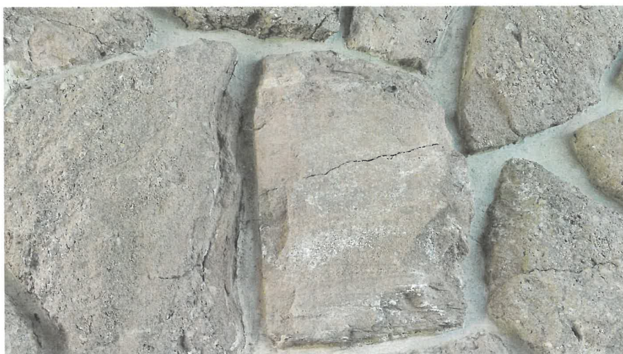
Obr. 2: Trhlina v místě vrstevnatosti nepravidelného kamenného bloku.
