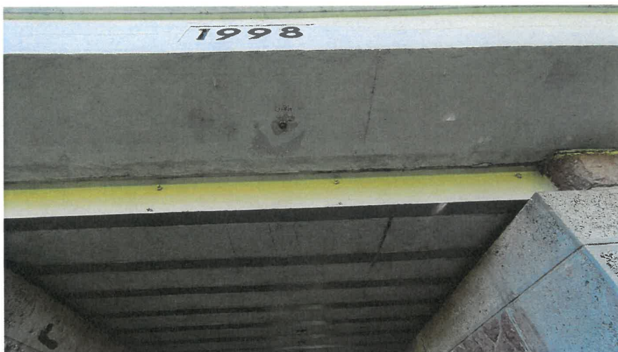
Obr. 19: Spodní líc prefabrikovaného římsového nosníku.
