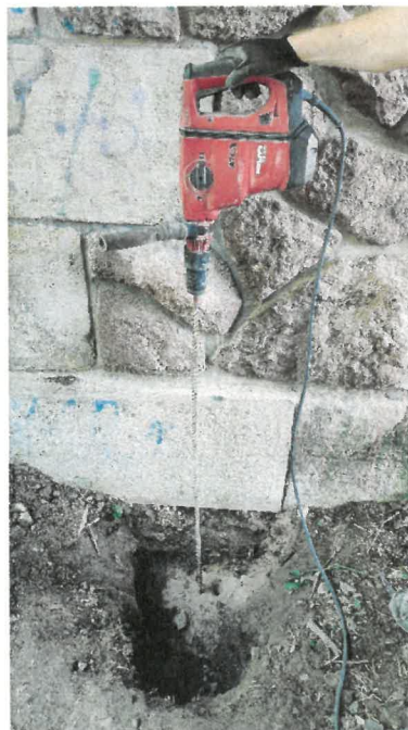
Obr. 24 a 25: Ověření úrovně základové spáry vrtanou sondou u opěry mostního objektu.
