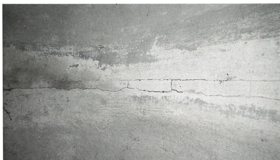
Obr. 5: Trhliny v místě napojení prefabrikovaných trub. Některá napojení dílců byla vyplněna cementovou maltou.
