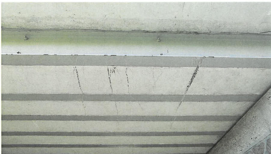
Obr. 5: Poškození nátěru krajních ocelových nosníků podjezdem nadměrného vozidla nebo jeho nákladu.
