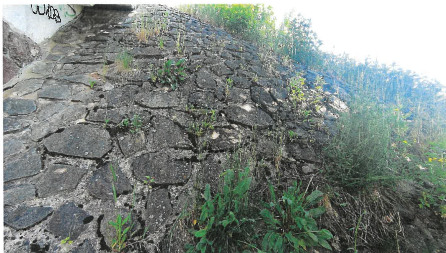
Obr. 23: Pokles kamenného obložení svahu podél kamenné opěry a křídla mostního objektu.
