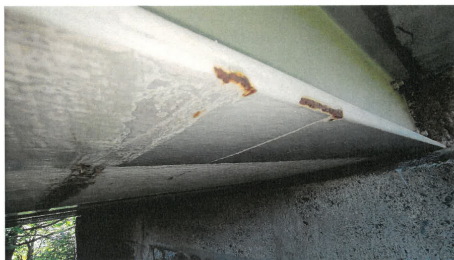
Obr. 15: Detail poškození nátěru krajních ocelových nosníků podjezdem nadměrného vozidla nebo jeho nákladu.
