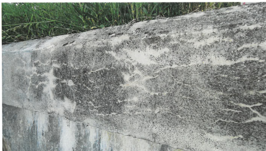
Obr. 6: Trhlinami porušená římsa propustku.
