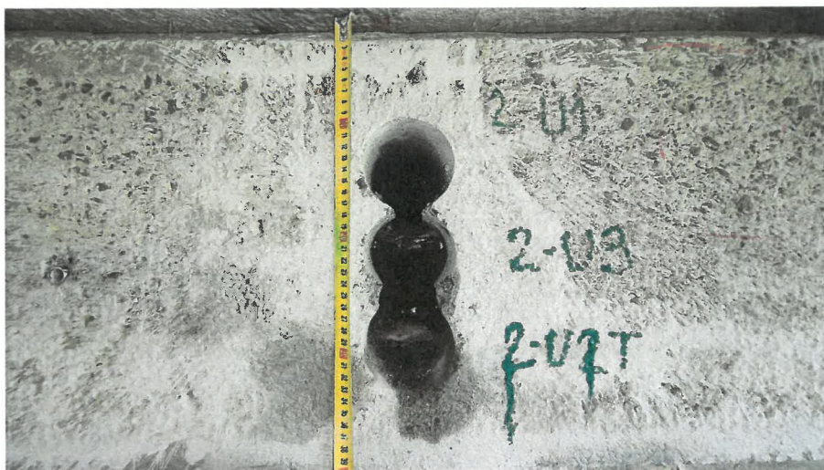
Obr. 10: Odběr jádrových vývrtů z úložného prahu č. 2. Orientace jádrových vývrtů byla směřována tak, aby bylo možné ověřit druh a tvar použité výztuže – použité kolejnice s výškou 115 mm.
