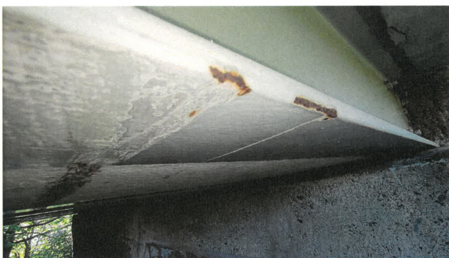
Obr. 6: Detail poškození nátěru krajních ocelových nosníků podjezdem nadměrného vozidla nebo jeho nákladu.
